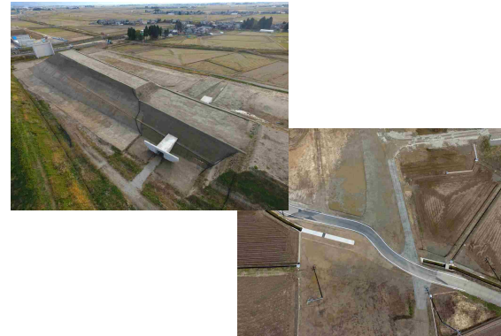
現場全景(完成時)
